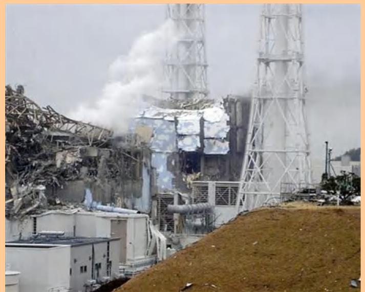
上の写真、左下から1号機・2号機・3号機で、1号機の建屋は爆発して上部が吹き飛び、3号機も爆発し建屋は崩壊。2号機は建屋の爆発こそなかったが、原子炉圧力容器の外側のコンクリート製格納容器が圧力上昇により穴が開き、放射性物質が噴出した。
