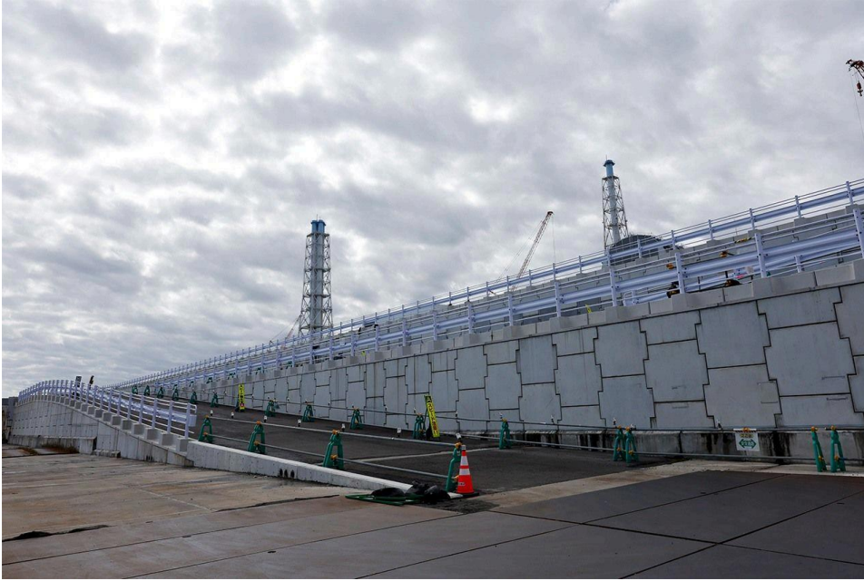
海側に築かれた津波対策の防潮堤。総延長は約1キロに及ぶ＝2024年10月21日、東京電力福島第1原発（土師野幸徳撮影）
