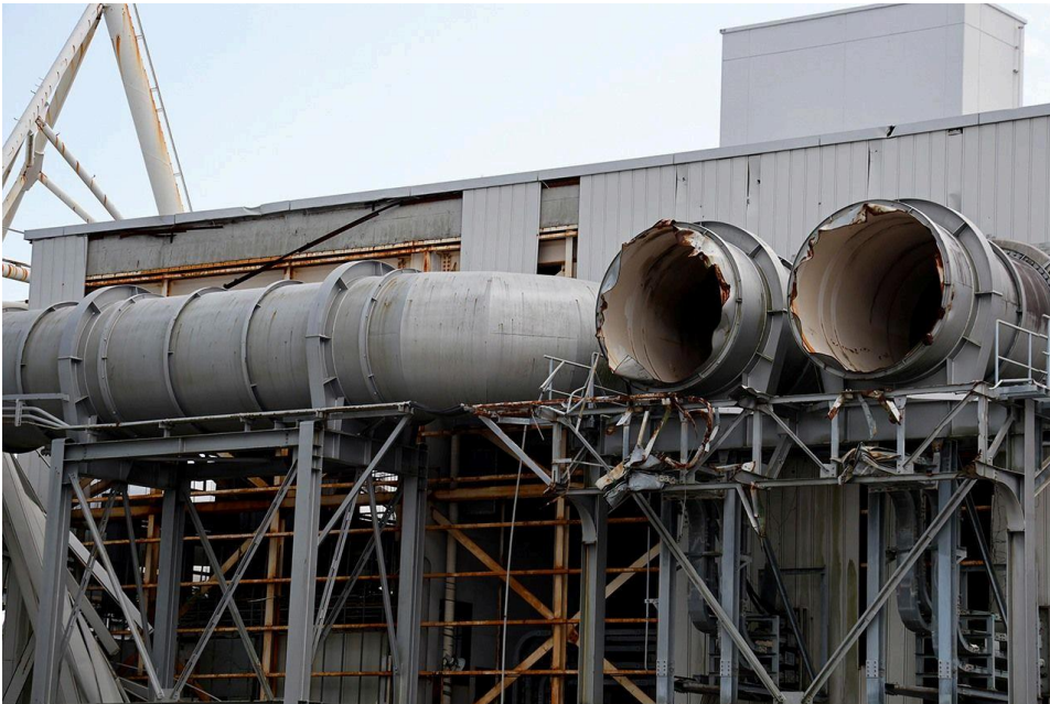
廃炉作業の邪魔になるとして切断された巨大な排気ダクト。かつては1~4号機から排気塔へつながっていた=2024年10月21日、東京電力福島第1原発（土師野幸徳撮影）
