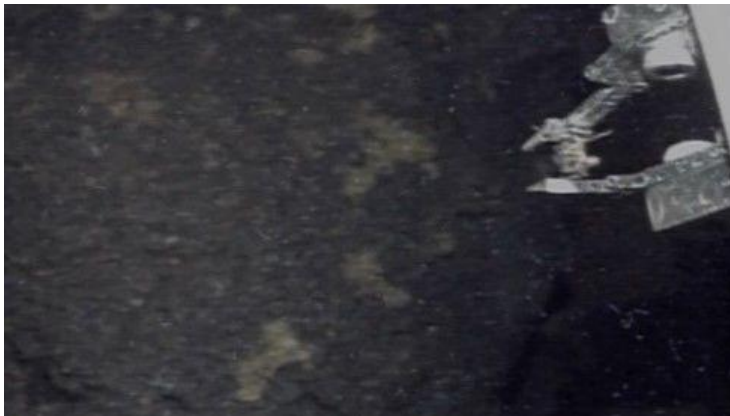
2号機の格納容器内の燃料デブリを専用装置でつまみ上げている様子。先端のハサミのような部分にデブリがある＝2024年10月30日（東京電力提供）
