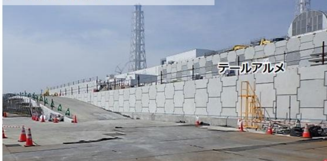
テールアルメ設置状況
