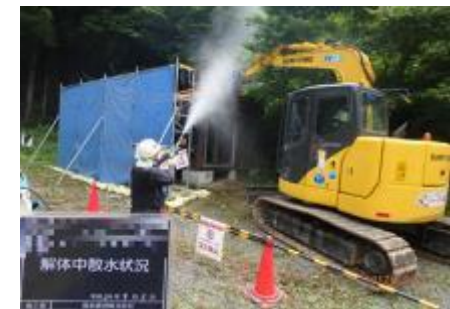
被災家屋等の解体の様子
