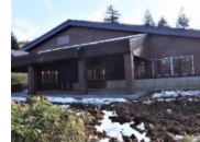
尾瀬沼ビジターセンター再整備
