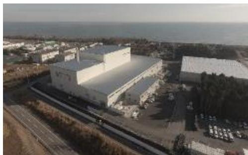
大熊町の仮設焼却施設(2017年12月)
