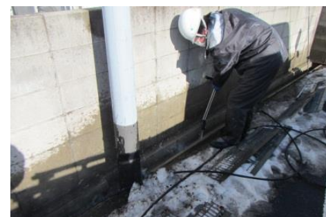
●側溝の汚泥の除去 (提供) 福島市
