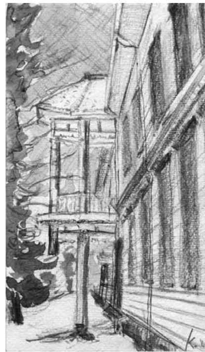
旧福島尋常中学校本館(側面より) 画:渡邊紘一(73期)
