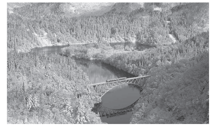
写真1 只見線第一橋梁（三島町只見線ビューポイントより）
