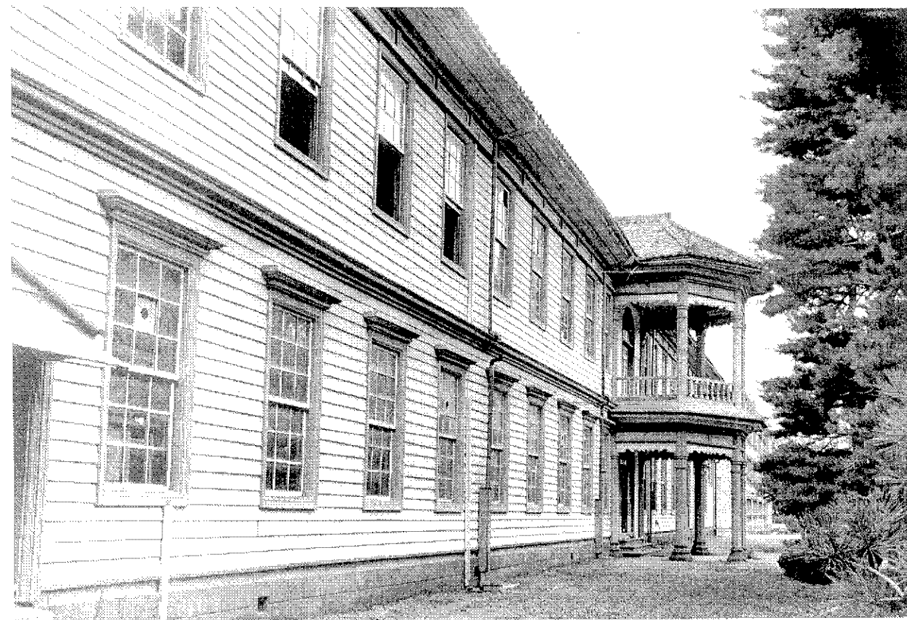
48 修理前 正側面
