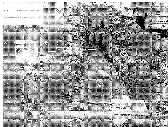
建物周囲の排水工事 （コンクリート製透水管を埋設した）
