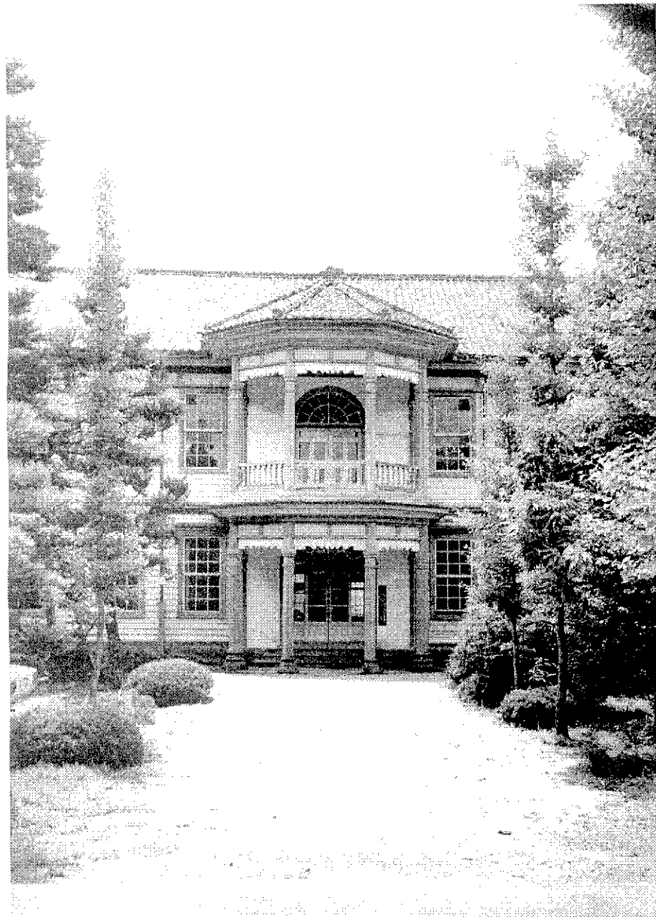
47 修理前 正面(北面)
