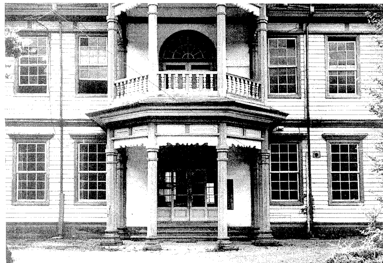
52 修理前 玄関廻り詳細 (1階前方の柱は後補である)
