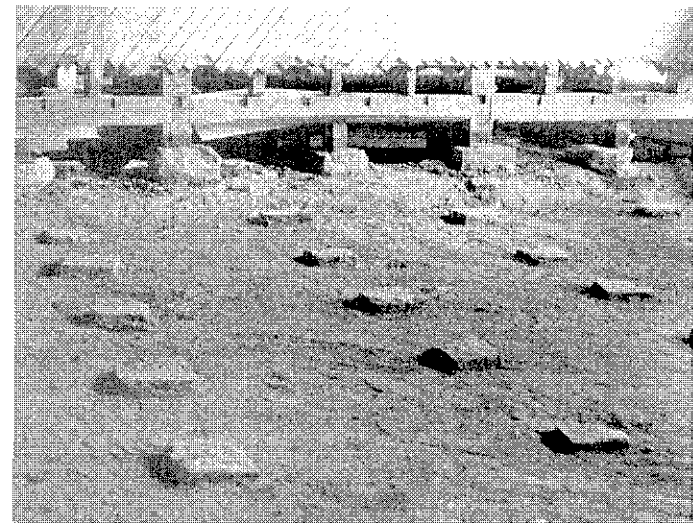
仕礎石、東石の状態（据直し、清掃完了）
