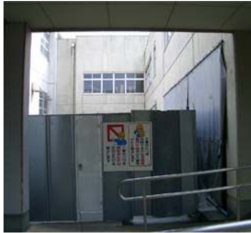
女子トイレと更衣室の増築工事が準備された仙台二高＝仙台市青葉区
